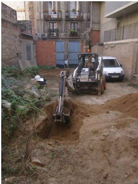
15. Obertura del sondeig 4
