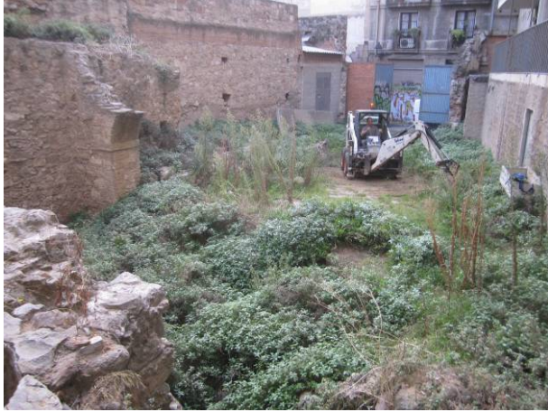
1. Vista del solar
