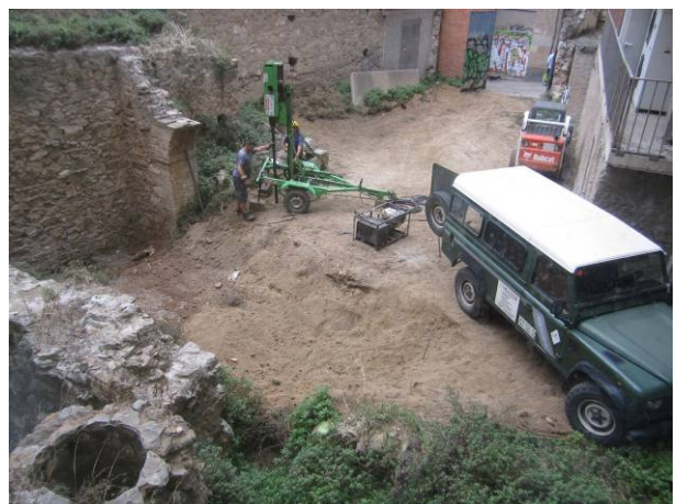
20. Vista general del solar
