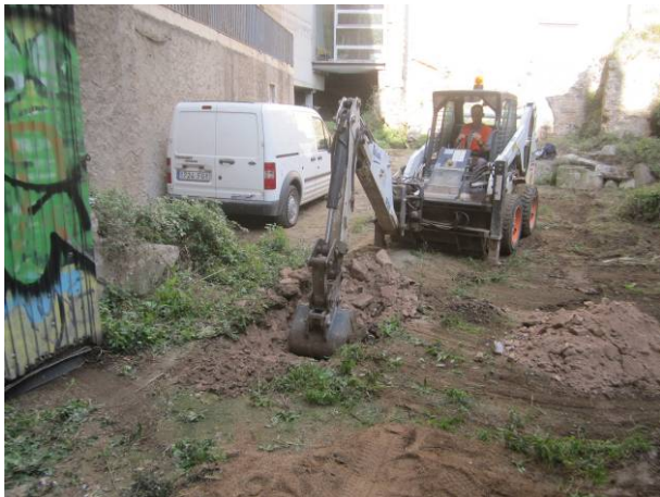
11. Obertura del sondeig 3
