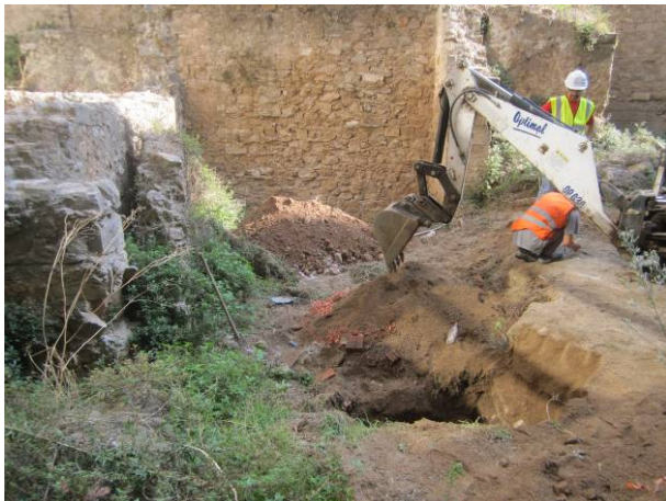
7. Obertura del sondeig 2
